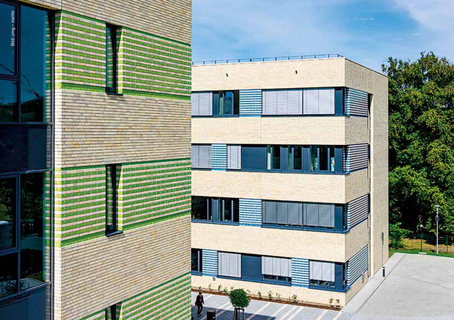
Zusammenarbeit architektonisch ermöglicht: Das neue U-förmige Forschungsgebäude beherbergt das BIN (grüner Teil) und das DZNE (blauer Teil).
